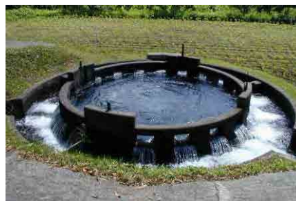
音無井路12号分水(円形分水)
