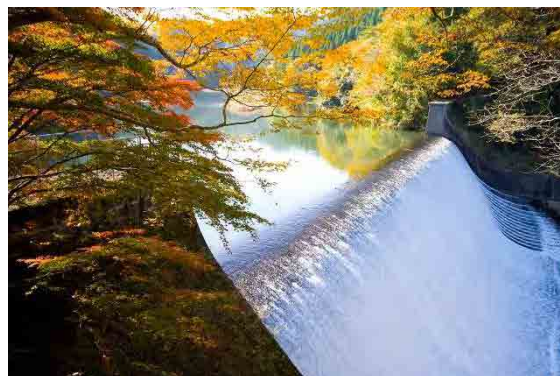
白水溜池堰堤水利施設
