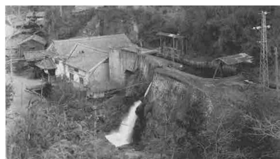
竹田水力発電所 第1発電所（明治末期）
