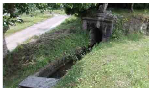
音無井路 2号暗渠入口
