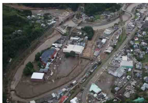
平成24年7月の九州北部豪雨による竹田文化会館周辺被災状況
