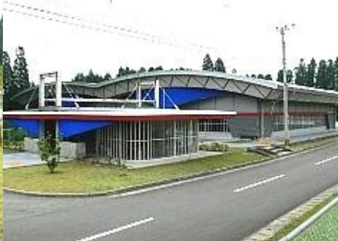
屋内ゲートボール場
