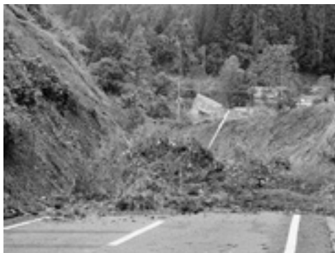
↑土砂で寸断された広域農道(宮砥地区)。
