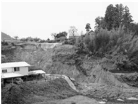
↑住家横から市道に渡っての崩落(豊岡地区)。
