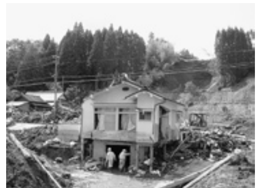
↑土砂に巻き込まれた住家(宮砥地区)。
