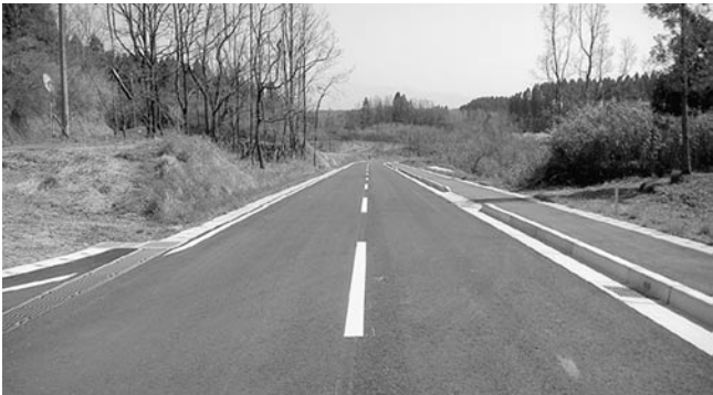
旧久住町 町道宮原米賀線道路改良事業 起債目的：過疎対策事業債他 借入先：日本郵政公社 簡易生命保険資金他
