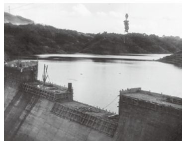
貯水しながら進めるえん堤工事 (昭和31年7月)
