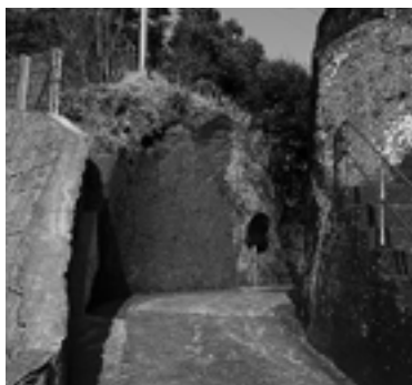
拡幅された道路（赤坂）
