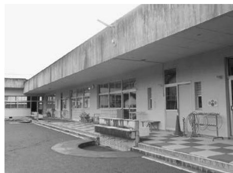
↑竹田幼稚園舎全景
