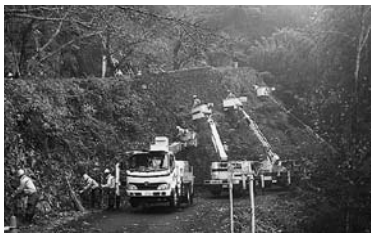
↑高所作業車で石垣清掃をする九電グループ職員のみなさん
