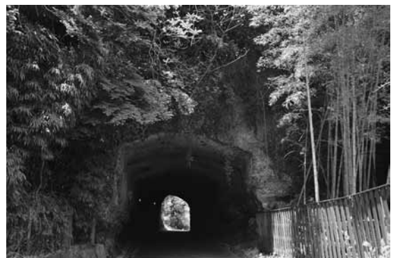
↑城北町と濁淵をつなぐ市道トンネル。上辺部分に五角形の斜辺に沿って掘られた形跡があり、中ほどの左手に祭壇らしきものが残っている
