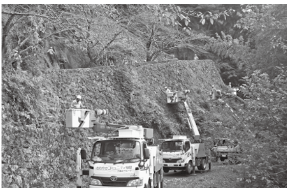
↑高所の作業車で石垣清掃をする九電グループ職員のみなさん
