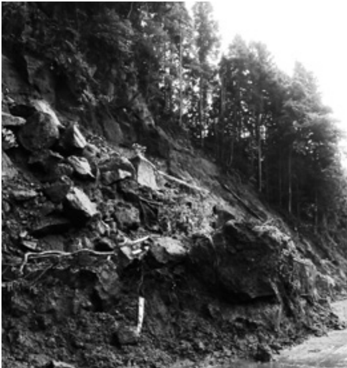
↑集中豪雨には警戒しましょう (昨年発生したがけ崩れの様子)
