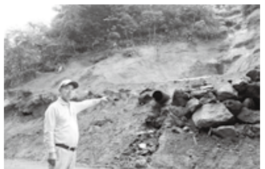
↑復旧した用水路現場を案内してくれた熊野理事長
