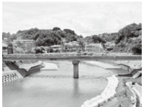
↑撤去される阿蔵新橋
