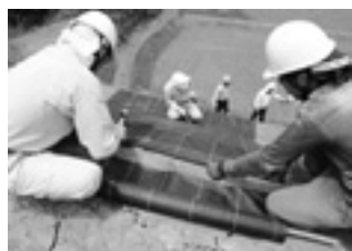
↑法面に植生シートを貼り付けます
