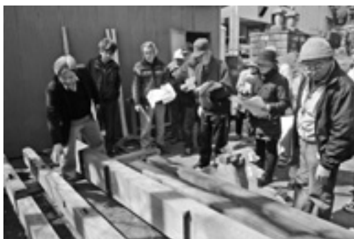
↑ 遙拝門の解体保存修理状況を説明
