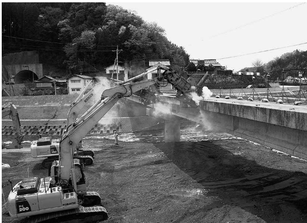
↑撤去工事が始まった阿蔵新橋
