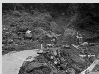
↑災害直後（滝水川治線南河内地区）
