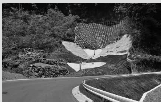
↑災害復旧後（滝水川治線南河内地区）
