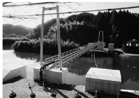
↑完成した「第一水源第一水管橋」
