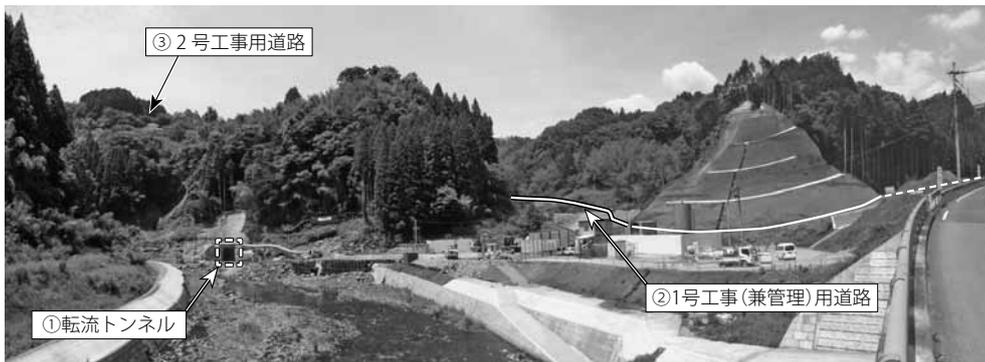
写真① トンネル延長L=288㍍、直径D=4.9㍍の馬蹄形です。
