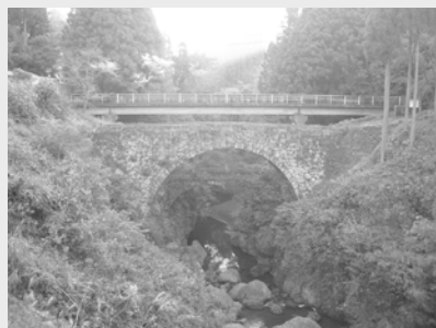
↑大分県指定有形文化財「岩戸橋」 河川：大野川水系岩戸川 形式：石造単アーチ橋 橋長：28.2m / 橋高：18m 径間(アーチ幅)：17.4m
