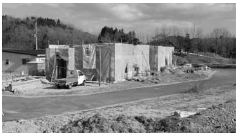
↑建設中の直入スカイビュー団地(27年12月現在)
