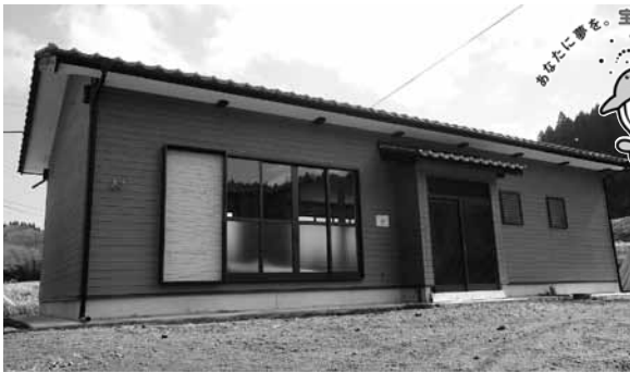
↑完成した添ケ津留自治会コミュニティセンター
