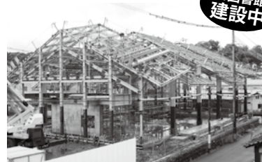
↑新図書館建設工事は本体のフレーム工事が概ね終了し、新図書館の全体像がイメージできるようになりました(10/5現在)
