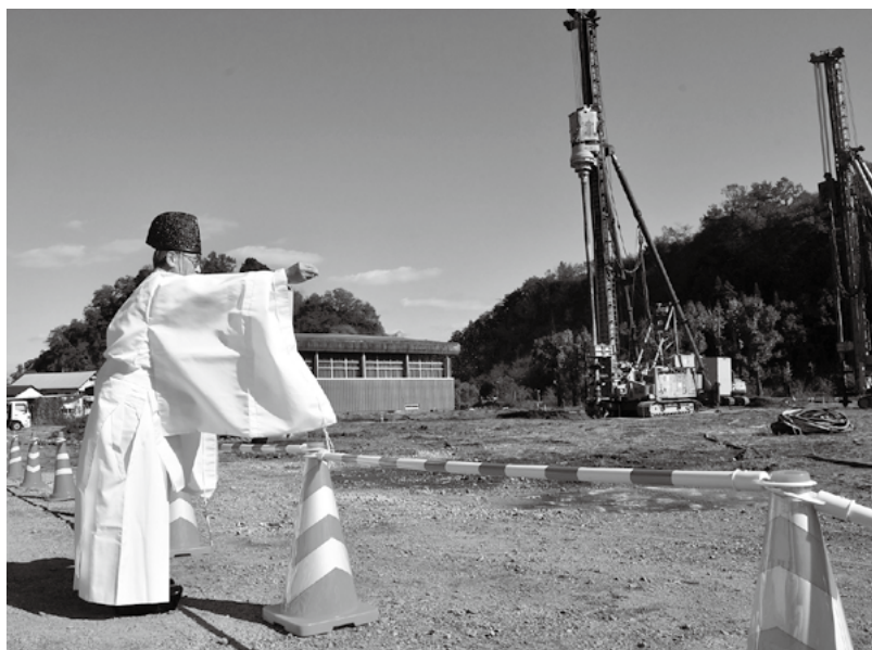
↑ 工事の安全を祈願して神事が行われた新文化会館建設予定地
