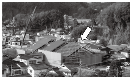
←12月中旬現在、順調に建築工事が進む新図書館
