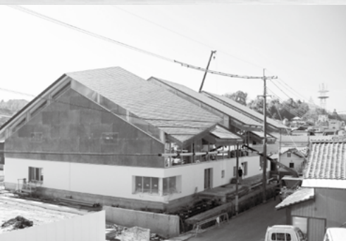
↑順調に建設が進む新図書館
