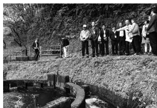
↑音無井路円形分水では、公平に水を分ける仕組みに多くの質問が出されていました
