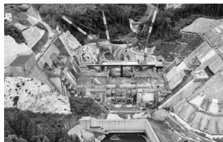
↑令和2年8月 コンクリート打設10万立方メートル達成
