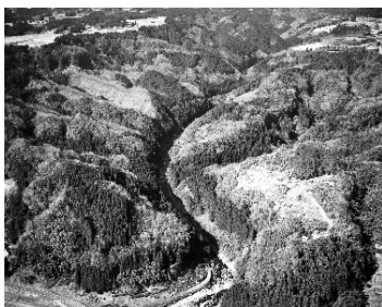
↑平成20年3月 着手前のダムサイト付近
