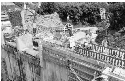
↑令和3年8月 本体コンクリート打設完了
