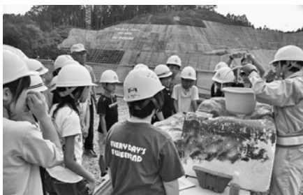
↑令和元年10月4日 玉来ダム土木未来教室
