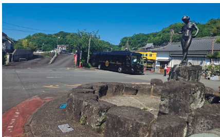
↑名水の庭は漏水し、現在使われていない
