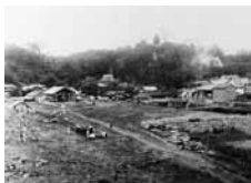
↑大正12年竹田駅工事
