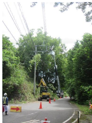
122径間（電柱と電柱の間） 6,200m
