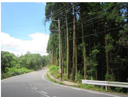
配電線周囲2mの上空 及び下部の支障木除去
