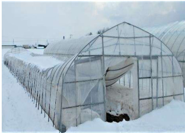
＜雪による被害の様子＞
