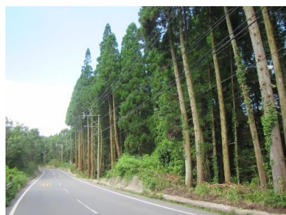
配電線周囲 2 m の上空及び下部の支障木除去
