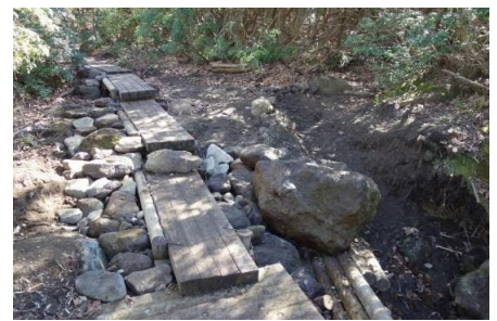
崩壊した沢を横断 する登山路復旧
