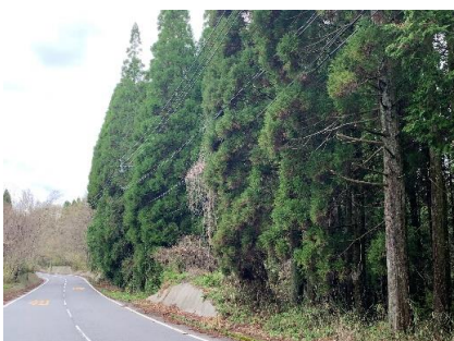
配電線周囲 2 m の上空及び下部の支障木除去
