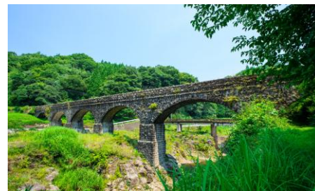
③明正井路(1924年築造)「第一拱(こう)石橋(せききょう)」(国内最大規模の石造水路橋・土木遺産)
