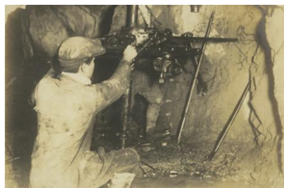
②荻柏原井路 (1924年築造) 電動削岩機を使用した岩堀削(当時) 水路工事では日本で初めての施工。
