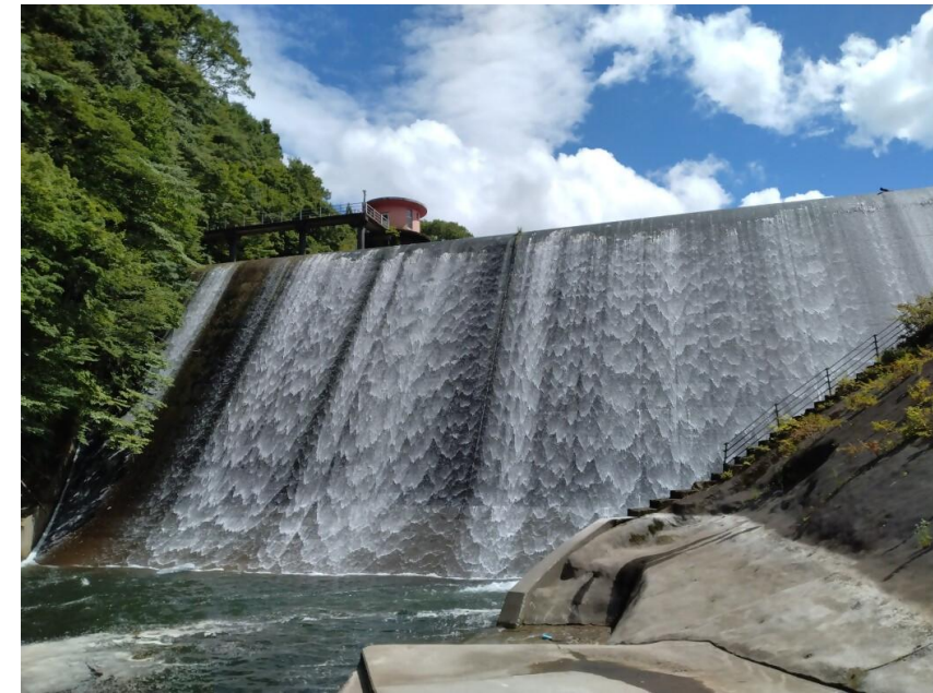
水を確保するために造られた、溜池のえん堤
