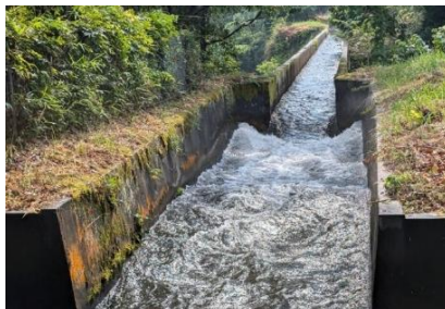
④富士緒井路(1914年築造)「四俣水路」 左側は 現在の水路の状況 中段は 築造当時(大正3年撮影) 右側は 白水ため池(関連施設)
