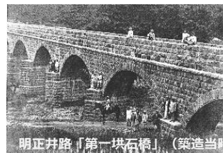
明正井路「第一拱石橋」(築造当時)
