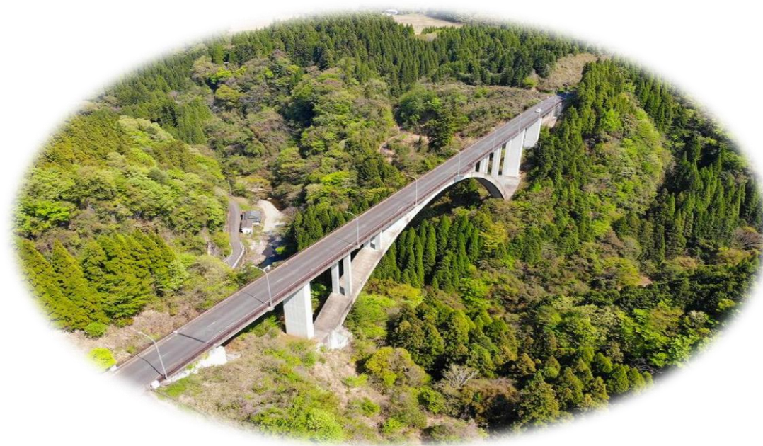
神原溪谷に架かるアーチ橋（神原溪谷大橋）
