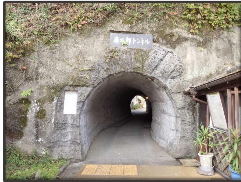
溝川トンネル(廉太郎トンネル)
