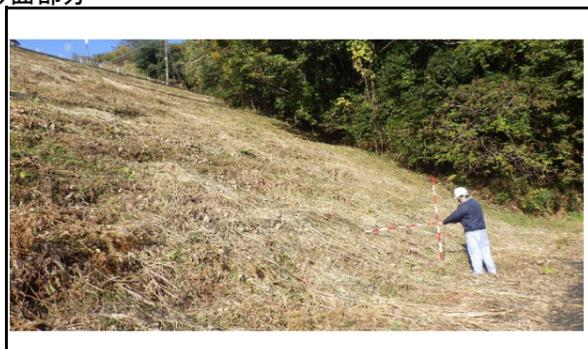
Point③ 盛土法面上の新たな亀裂、はらみ出しや湧水の有無を確認
