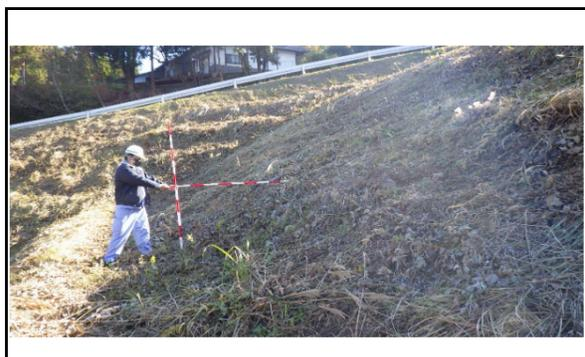
Point⑥ 盛土法面上の新たな亀裂、はらみ出しや湧水の有無を確認
