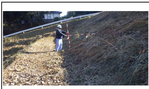
Point④ 盛土法面上の新たな亀裂、はらみ出しや湧水の有無を確認
