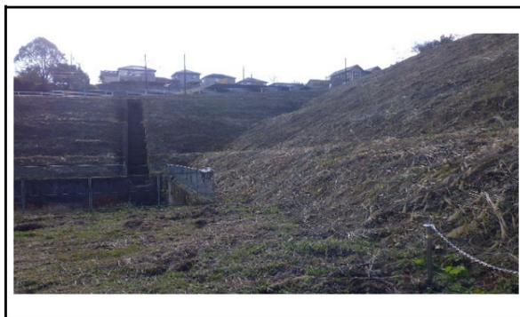
Point⑤ 盛土法面上の新たな亀裂、はらみ出しや湧水の有無を確認
