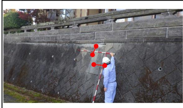
Point① 測量ピンを打ち、2点間の距離を測定
