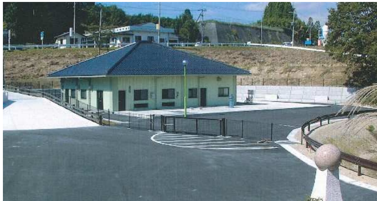
写真 -1 久住地区農業集落排水施設（竣工時）
