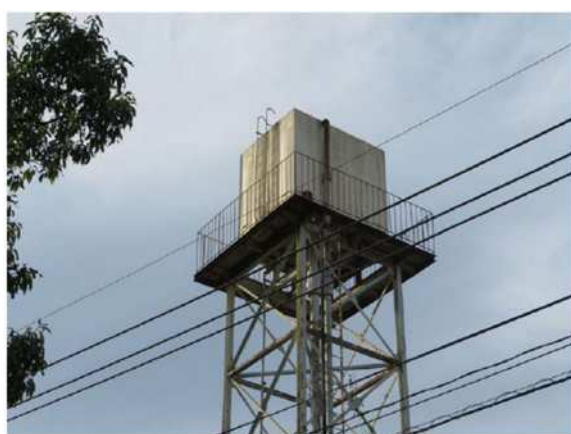
写真-1 玉来スカイコート配水池
