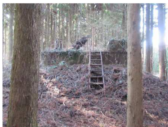
写真-2 仏面配水池
