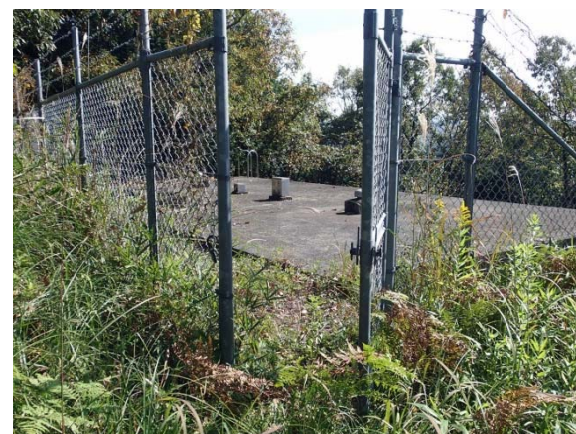
写真 5.3.7 直入中央第 1 配水池(現況)
