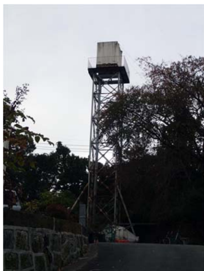
写真 5.3.4 効仁ト高架水槽(現況)
