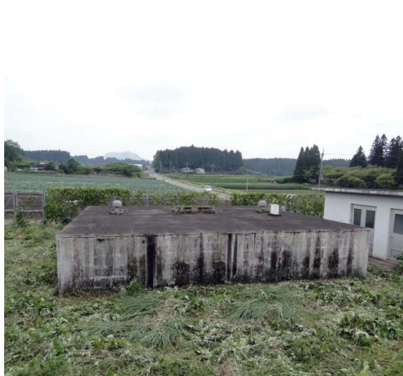
写真 5.3.5 荻下ノ原配水池(現況)
