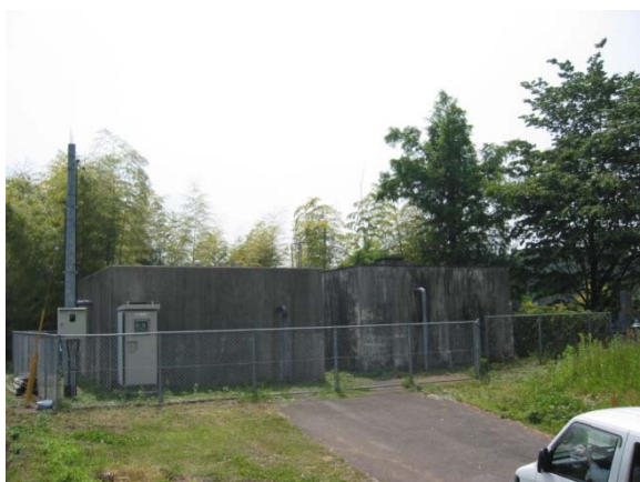
写真 5.3.6 久住低区第 1 配水池(現況)
