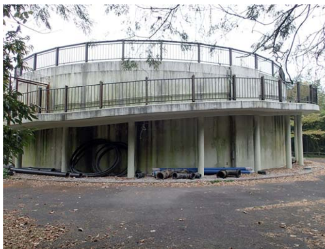
写真 2.2.1 第 1 高区配水池（上水道）
