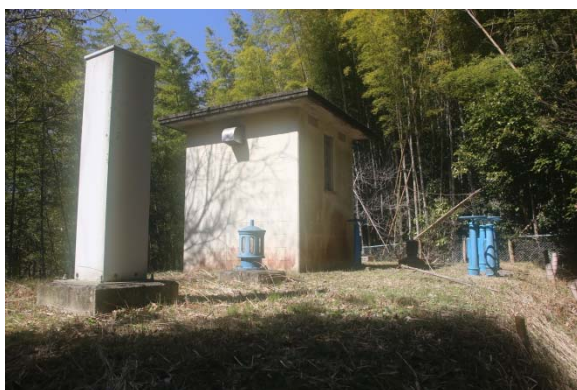
写真 5.3.2 上水道第 4 配水池(現況)
