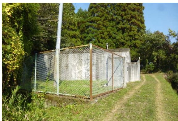
写真 5.3.3 上水道第 5 配水池(現況)
