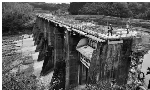
↑水門の工事をしています
