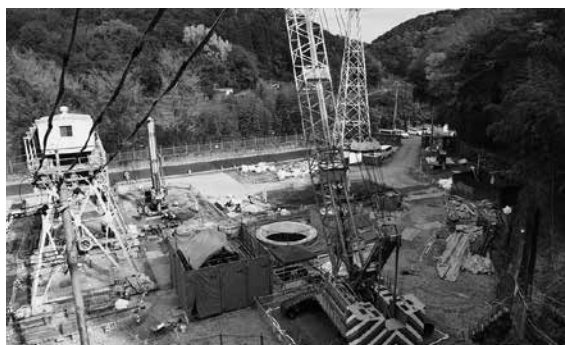
↑設備を取り替え中の竹田発電所
