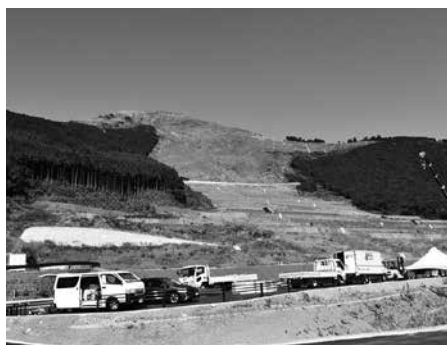
↑阿蘇大橋地区斜面对策箇所
