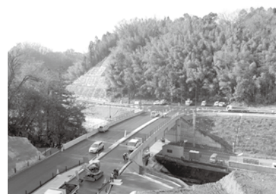
↑開通に向け、工事が進む竹田IC付近
