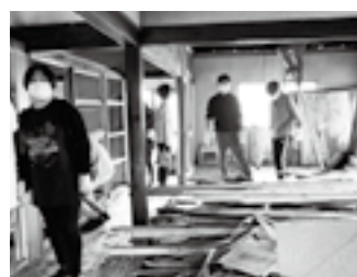
↑リフォーム中の古民家。完成後はアートを通じた地域住民との交流拠点に
