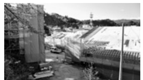
↑ 工事が進む竹田市歴史文化館
