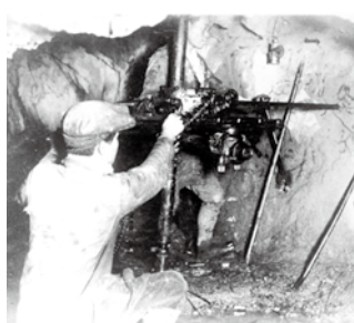
↑削岩機による隧道掘削
