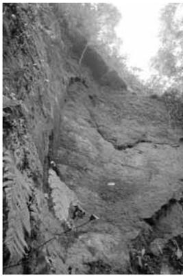
←西中仕切の石垣を支える岩盤が崩落したことにより、石垣が浮き不安定な状態に
