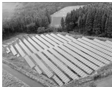
↑長野県飯田市の市民エネルギー発電所
