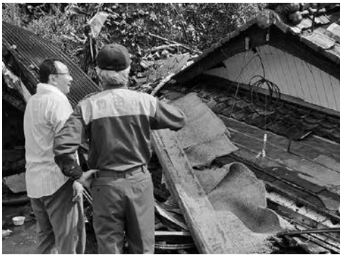
←土砂災害により倒壊した家屋を視察 (直入町)
