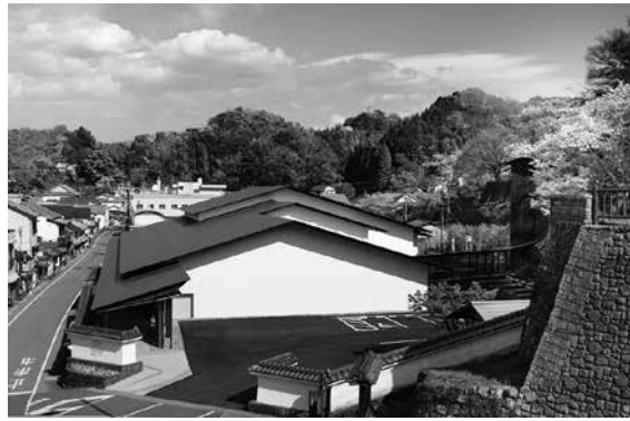
〔撮影〕川澄・小林研二写真事務所 浜田昌樹
