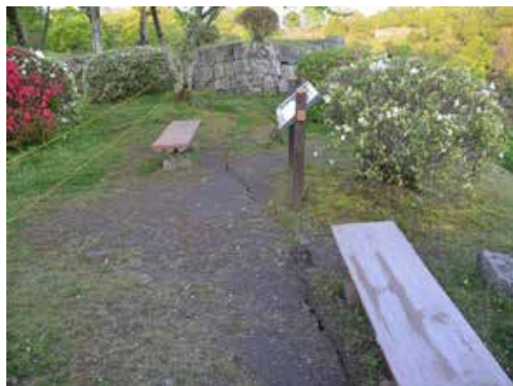
岡城跡三の丸、亀裂状況（熊本地震）
