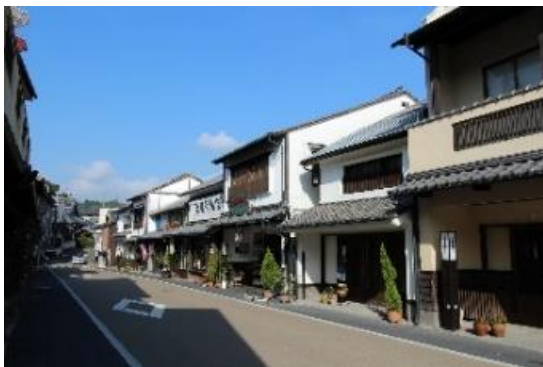
電線類無電柱化を実施した通り
