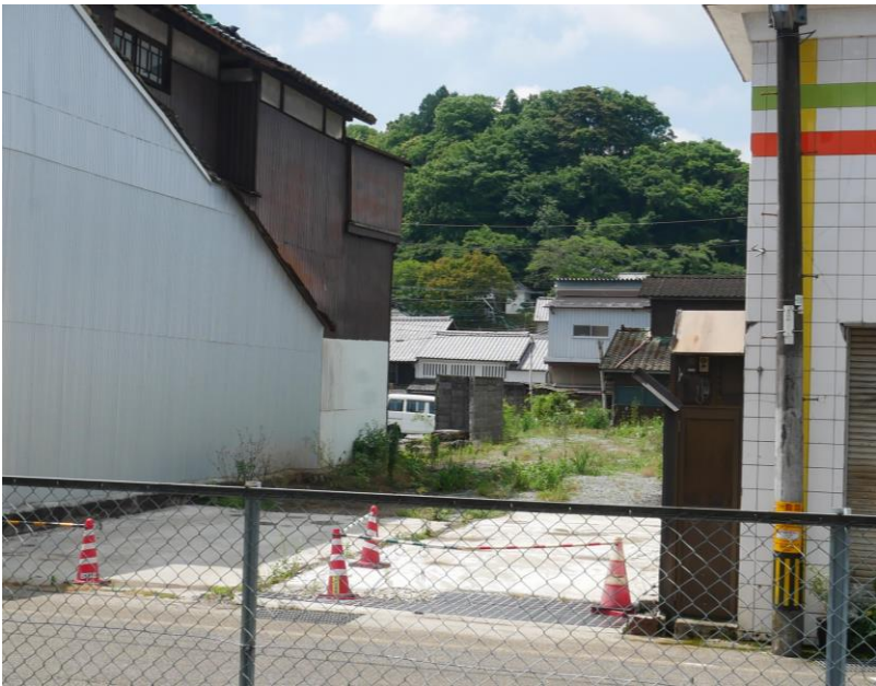
老朽家屋除却後
