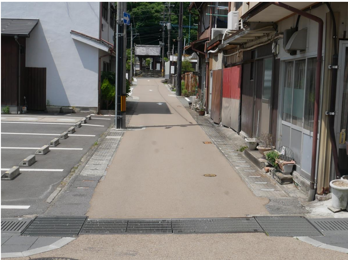
道路美装化状況
