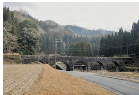
明正井路第一拱石橋
