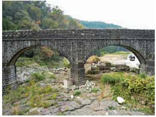
明正井路第一拱石橋
