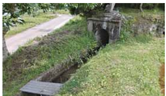
音無井路暗渠入口
