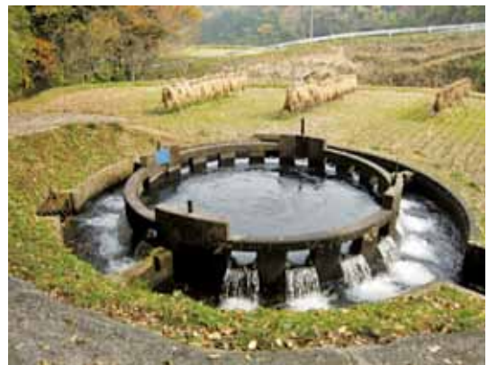
音無井路 12 号分水
